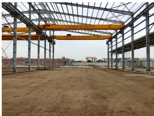
Chế tạo hệ thống cầu trục
