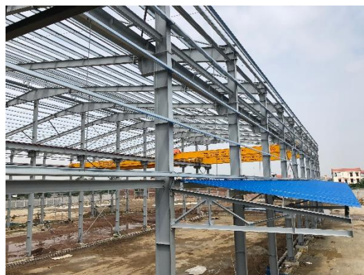
Lắp dựng kết cấu thép
